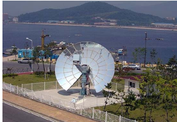
경남 진해시 에너지환경과학원에 설치된 Dish형 태양열발전시스템
